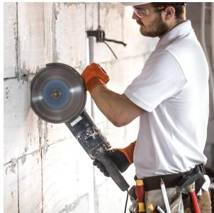
Disco Diamantado Segmentado Kern Deudiam 9 Pulgadas Multimaterial 24-145, indicado para cortes en concreto curado, concreto reforzado y tubos de concreto, de corte rápido y larga vida útil, el Disco Diamantado Segmentado Kern Deudiam posee segmentos de alto performance elaborados con soldadura laser tecnología alemana.
