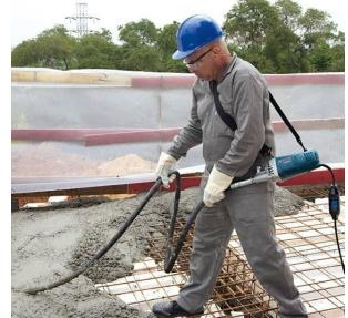
Vibrador para Concreto Bosch GVC 22EX 2.9Hp 20.000rpm, el mejor en la compresión de concreto con 20000 revoluciones por minuto mas que otras marcas, además de la mejor relación peso / potencia. No incluye eje ni cabezote.
